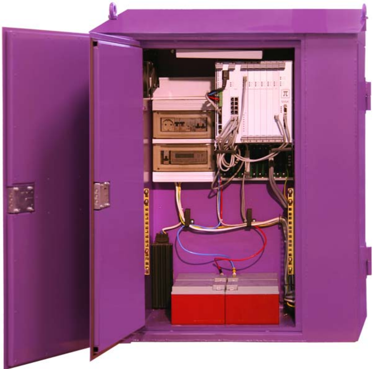
Рис. 2 Монтаж оборудования в пристенном шкафу
